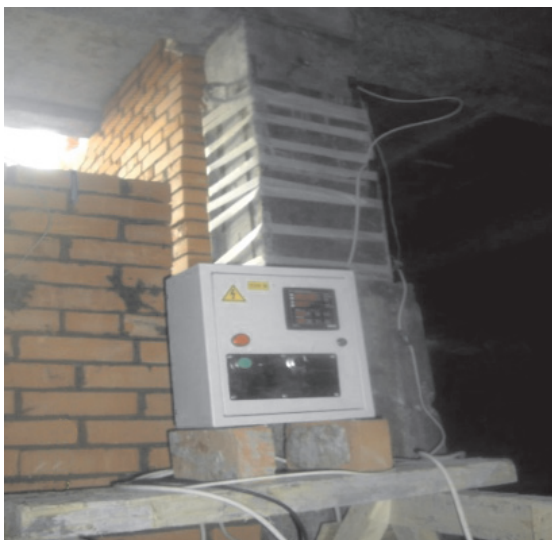
Рис. 1. Установка термоактивной опалубки для обогрева шпунтового соединения колонны и фундамента
